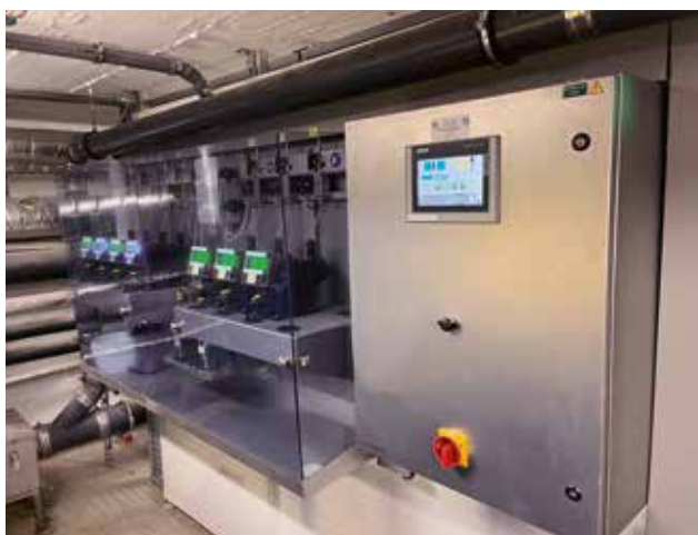
Das Dosier- und Steuersystem weigomatic® proSMART touch kann mehrere große Spülmaschinen gleichzeitig versorgen und sämtliche Verbrauchsdaten erfassen.
