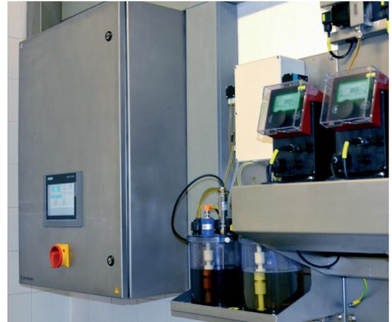
Durch die im Fass integrierte Sauglanze wird eine nahezu vollständige Restentleerung sichergestellt. Zwischenbehälter sorgen dafür, dass genügend Zeit für den Fasswechsel bleibt. Durch eine optionale Gebindeumschaltung, kann auch dieser Schritt noch perfektioniert werden.
